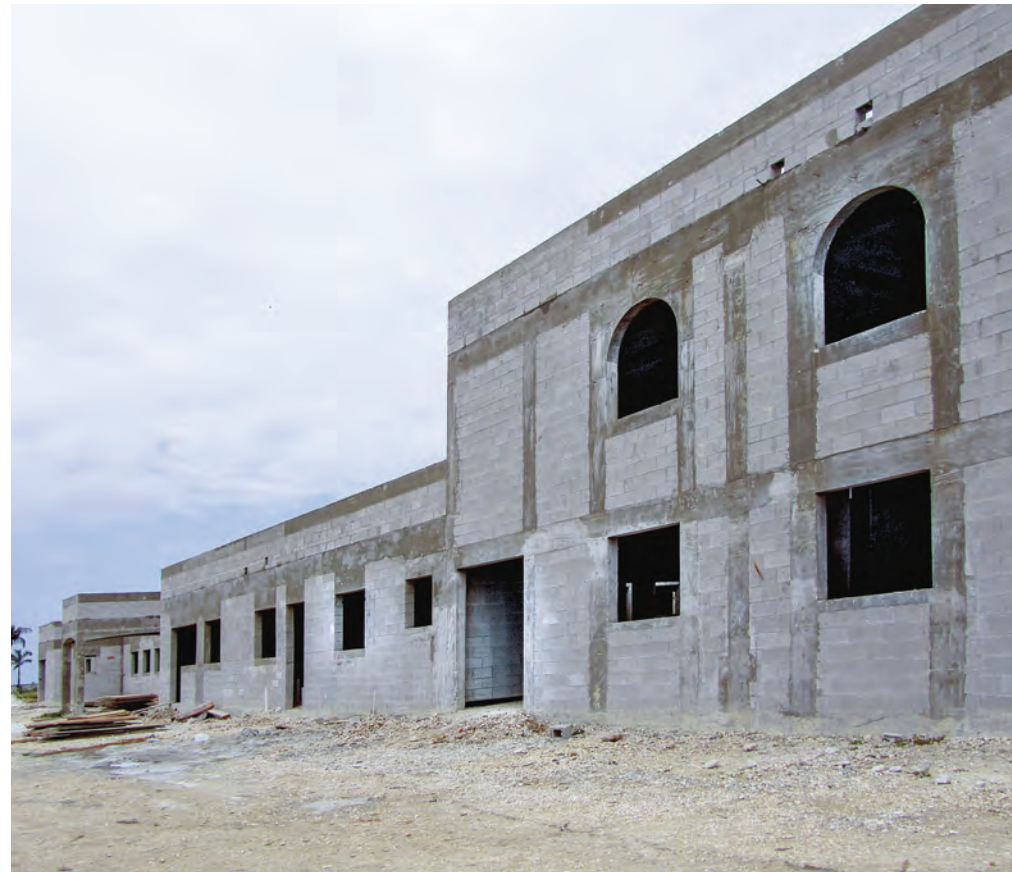
El monasterio todavía en construcción.
